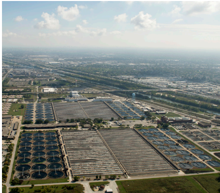
Planta de Tratamiento de Agua Stickney y Canal Sanitario y de Navegación de Chicago
