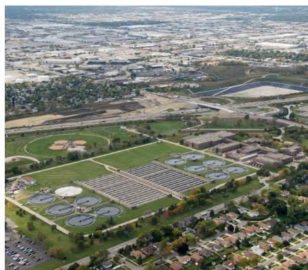
Oczyszczalnia ścieków Kirie
