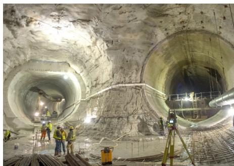
Construcción en la confluencia del túnel de conexión del depósito McCook (izquierda) y el túnel principal (derecha)
