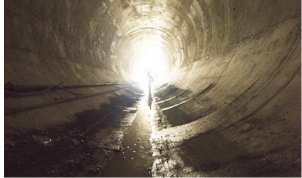
El Plan de Túneles y Embalses (TARP) captura las aguas residuales y pluviales durante las fuertes lluvias para evitar desbordes del alcantarillado, reteniendo el agua hasta que pueda ser tratada.
