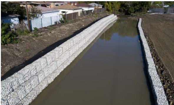
Las mejoras de los canales despejan y ensanchan los cauces para mejorar el flujo del agua y prevenir la erosión.
