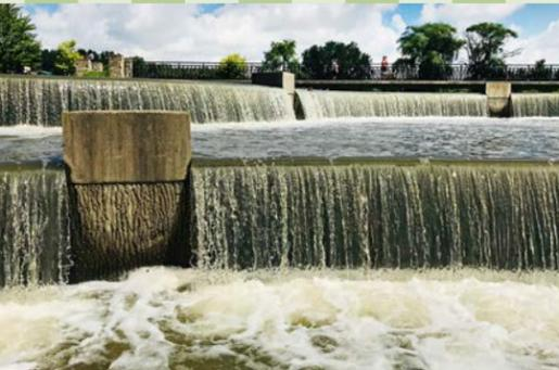
**NOTA DE LA MAESTRA** La SEPA es un acrónimo para aireación por medio de piscinas elevadas (Sidestream Elevated Pool Aeration.) El MWRD construyó cinco estaciones de SEPA en el condado de Cook, junto al canal Calumet-Sag y el río Calumet. Cada estación cuenta con una cascada que le aporta oxígeno al agua. ¡Más oxígeno en el agua es bueno para los peces!
