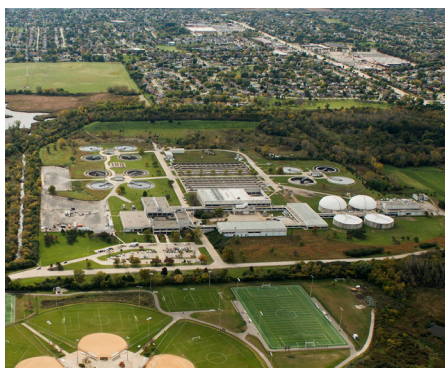
Planta de Tratamiento de Agua Egan
