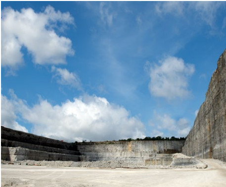
Embalse Thornton durante excavación, que es parte del sistema TARP en Calumet.
