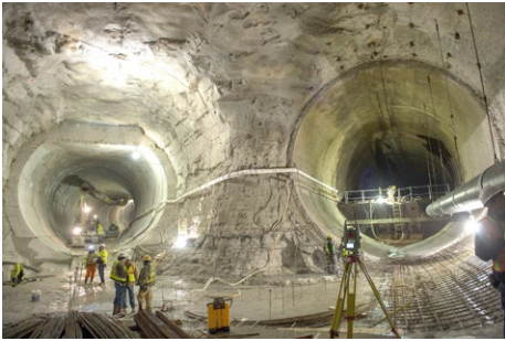
Construcción en la confluencia del túnel conector del embalse McCook (izquierda) y el túnel de flujo principal (derecha).
