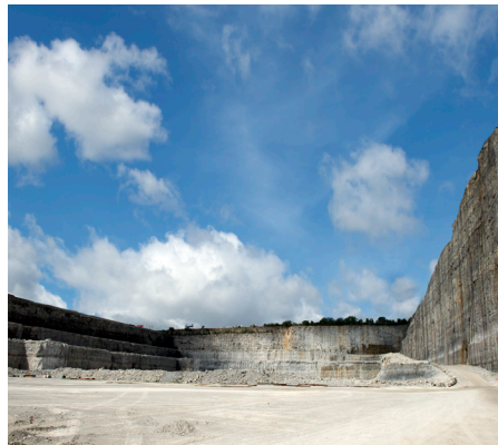
Zbiornik Thornton o pojemności 7,9 mld galonów, część systemu Calumet TARP.
