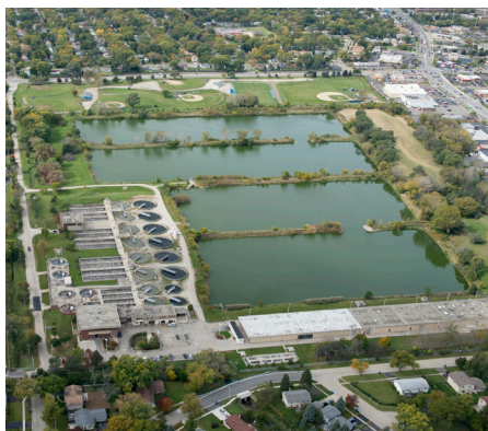
Oczyszczalnia ścieków Hanover Park
