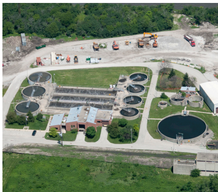
Oczyszczalnia ścieków Lemont
