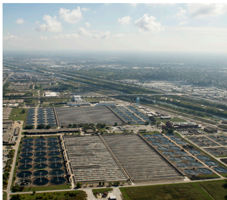
Oczyszczalnia ścieków Stickney oraz Chicago Sanitary and Ship Canal
