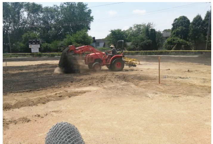
Tractor con cucharón para aplicación de grandes cantidades de biosólidos para restaurar campos de juego.
