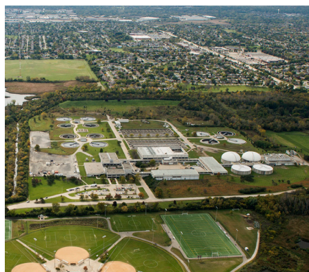
Oczyszczalnia Ścieków Egan
