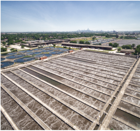
En 36 acres de tanques de aireación, un proceso biológico remueve los sólidos suspendidos y disueltos de las aguas negras.
