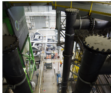
La planta de recuperación de nutrientes del MWRD, con sus tres enormes reactores, puede recuperar más del 85 % del fósforo y hasta el 15 % del nitrógeno del agua que se limpia en la planta.
